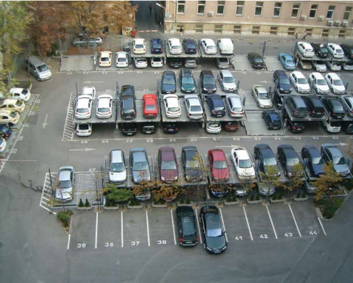
Vista dall'alto di sistemi di parcheggio Parklift 411 sia singoli che doppi installati in un parcheggio all'aperto. Le piattaforme si sbloccano automaticamente tramite pulsantiera di comando senza eseguire alcuna operazione manuale.
