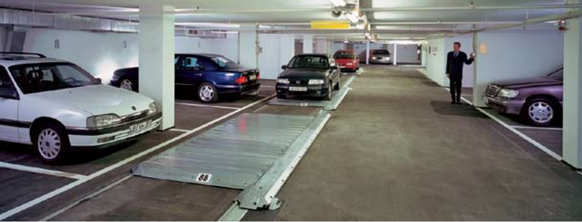
Piattaforme di parcheggio traslanti longitudinali 503 installate sulla corsia di manovra di fronte a posti auto convenzionali consentono di ottenere tre posti auto aggiuntivi.
