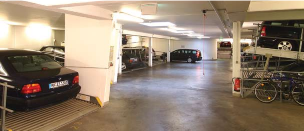
Sistemi di parcheggio IP2-I ed IP4-I singoli e doppi installati all'interno di un'automobili. Le piattaforme inclinate sono dotate di fermaruote che bloccano la vettura in sicurezza segnalando allo stesso tempo l'esatta posizione di parcheggio.
