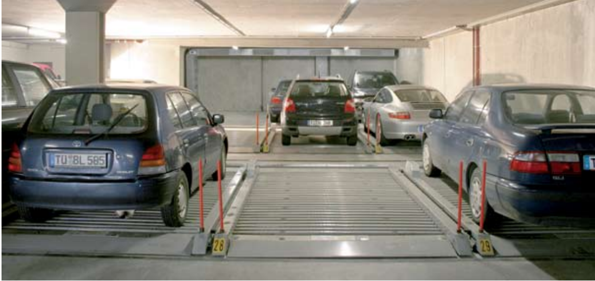
Piattaforme di parcheggio traslanti laterali 501 installate in serie su tre file di posti auto permettono di utilizzare tutto lo spazio dell'autorimessa con rimozione indipendente di tutte le vetture.
