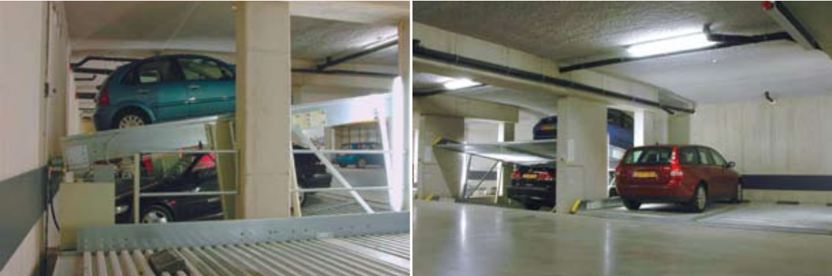
Vista laterale del sistema di parcheggio Parklift 402 doppio per quattro auto con rimozione indipendente. La piattaforma superiore è orizzontale in fase di riposo mentre si inclina durante il sollevamento per accedere ai posti auto interrati.
